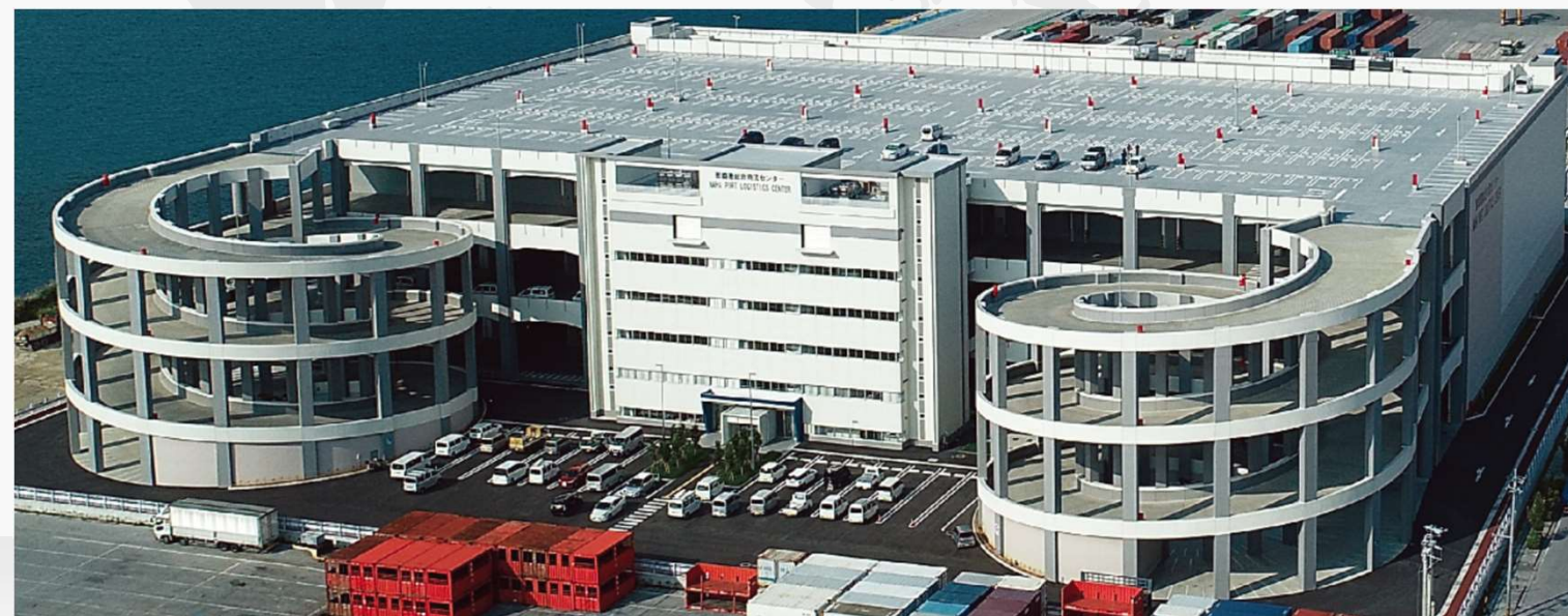
国内貨物取扱岸壁から東面を撮影
