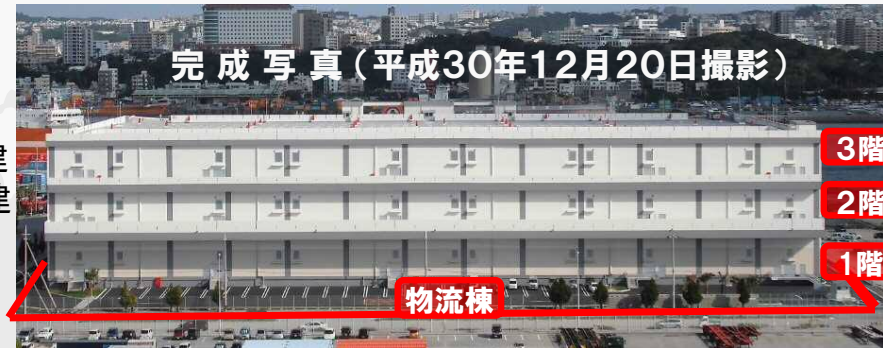
国際コンテナターミナルから西面を撮影
