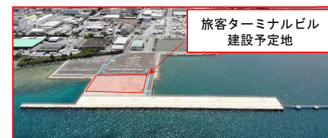
新港ふ頭12号岸壁(第2クルーズバース)
