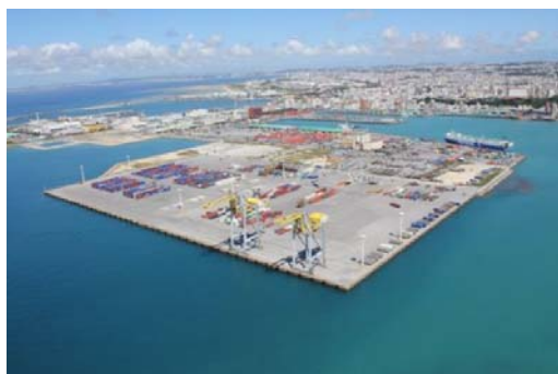
【ガントリークレーン及びリーファー電源整備予定地(新港ふ頭地区)】
