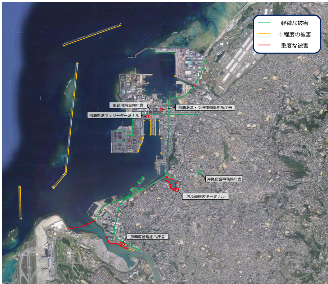
図 3-1 那覇港における被害の全体図
