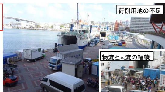
■泊ふ頭地区の狭隘状況
